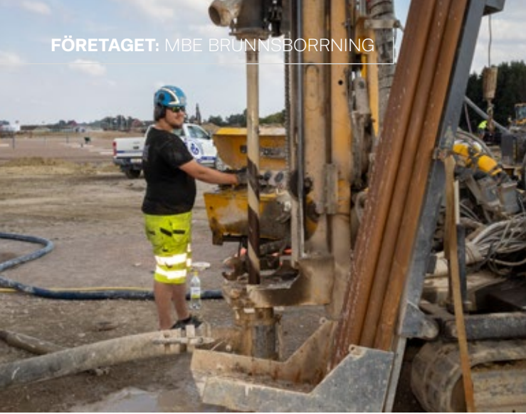
Sebastian Nilsson är praktikant på MBE och övervakar riggen i Löddeköpinge, där man är med och borrar energibrunnar för ett nytt köpcentrum.
